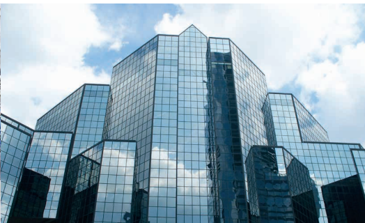
Automatización de Edificios
