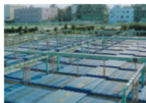
planta de tratamiento de agua
